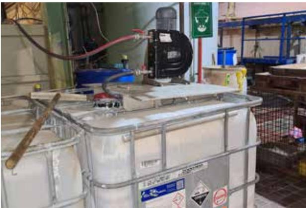
FHP 15: Fördern von 45%iger, abrasiver Kalkmilch aus einem 1.000 l IBC in Vorlagebehälter der Abwasseranlage.
