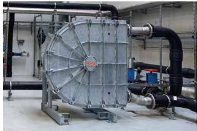
Fördern von feststoffhaltigem Abwasser: die PERIPOWER erreicht Fördervolumen von bis zu 300 m<sup>3</sup>/h.
